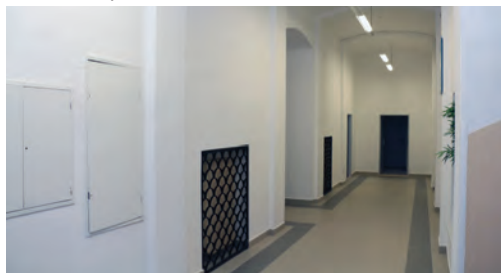
Přízemí v budově školy v ul. Školní 101 (po rekonstrukci)
