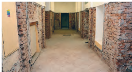
Přízemí v budově školy v ul. Školní 101 (v průběhu rekonstrukce)
